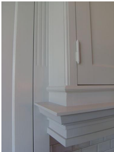
Bänkskåp med pärlspontsida, sockellådor, skärbräda, hörnfas och anslagslist på Luckan.
